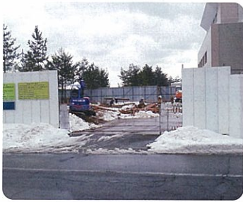
建設中の御所野児童センター
